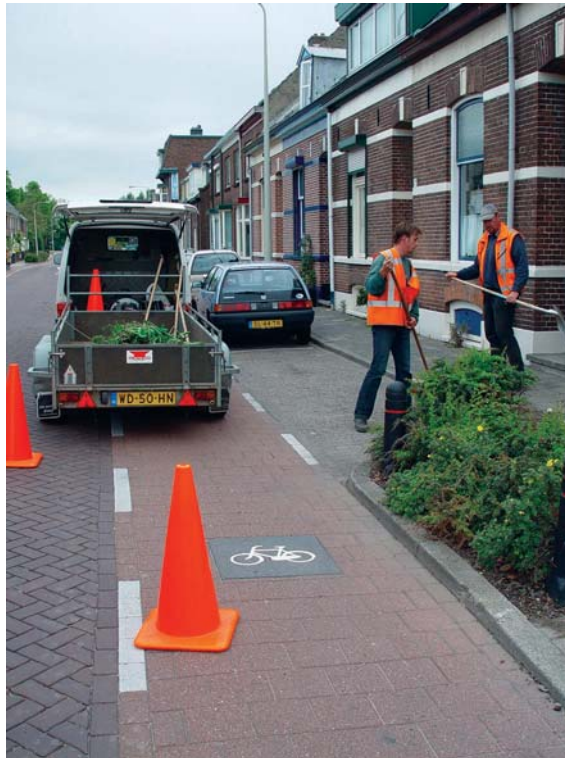
Figuur 1.10 Als je langs de weg werkt, moet je signaalkleding dragen en de weg afzetten.
