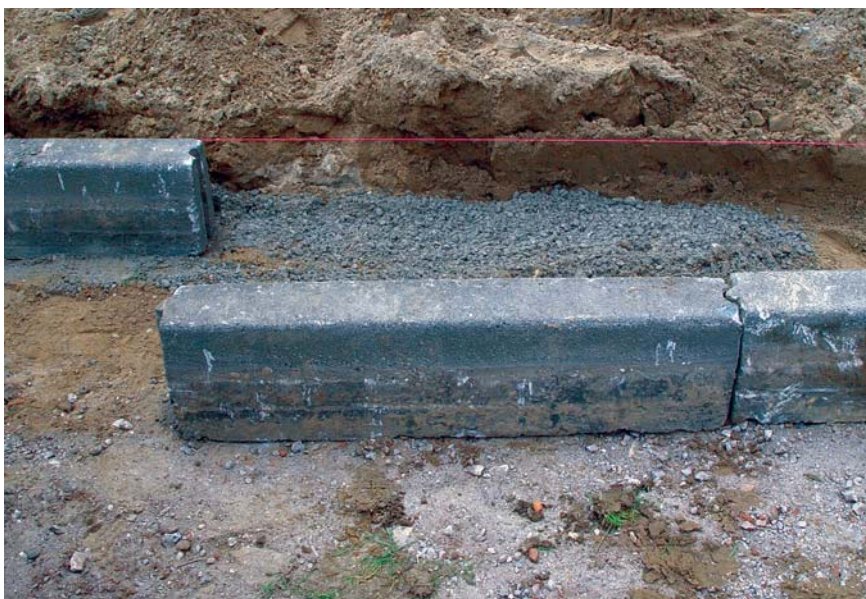
Figuur 2.7 Voordat je de klinkers legt, plaats je betonbanden in het cunet.
