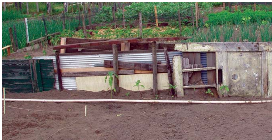
Figuur 2.13 Afrastering gemaakt van afvalhout en golfplaten
