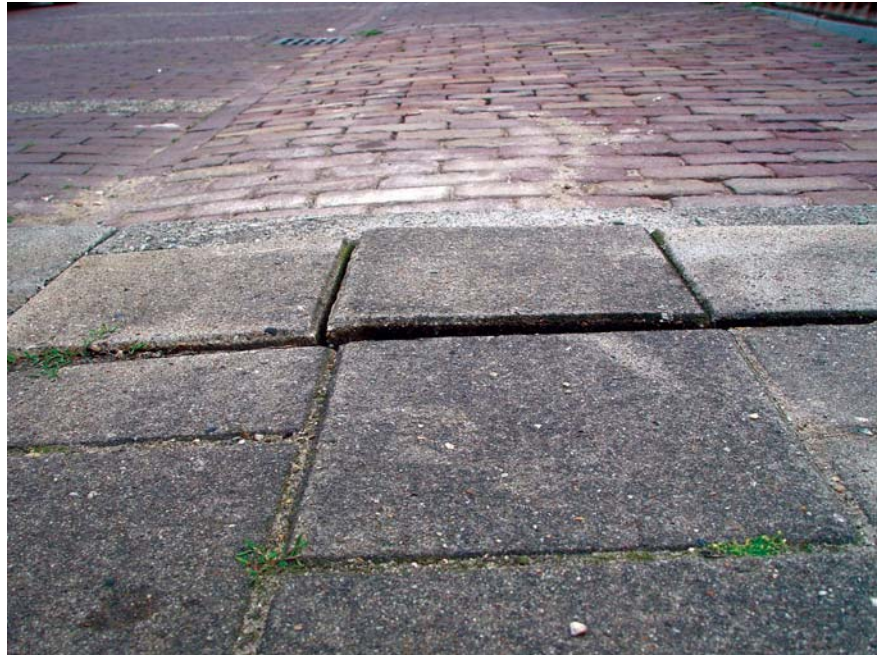
Figuur 2.6 Een scheef tegelpad kan ernstige gevolgen hebben.
