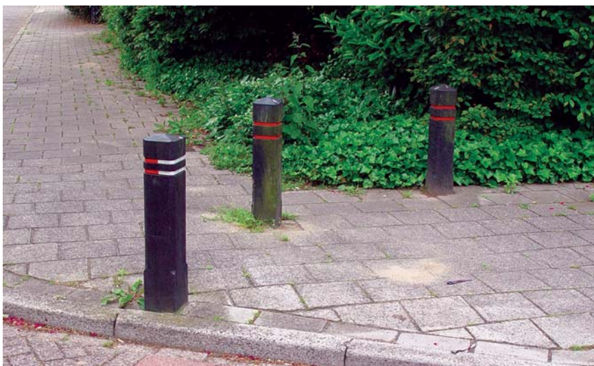
Figuur 2.3 Veel palen worden gemaakt van gebruikt plastic.
